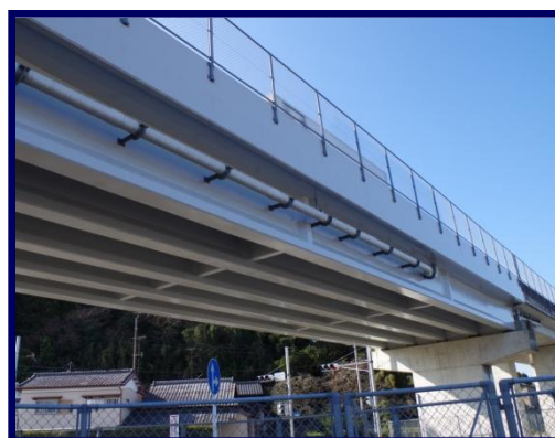
橋梁・トンネル補修・補強
